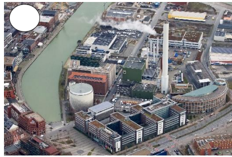
(Quelle: Stadtwerke Münster 2020)
